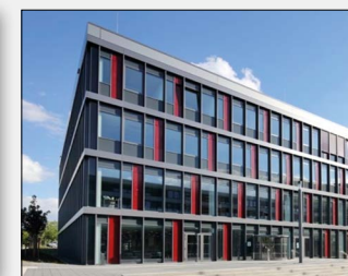
Elementos de fachada/parapetos
