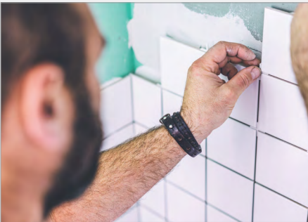
укладка керамической плитки
