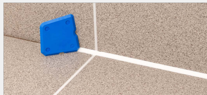
Liscitura manuale con spatola in plastica
