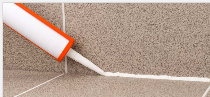
Rasatura dei giunti di tenuta/incollaggio
