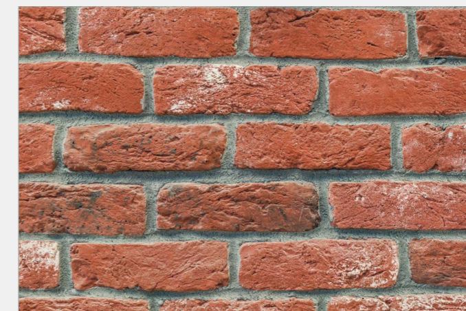
Pulizia di facciate in pietra e calcestruzzo
