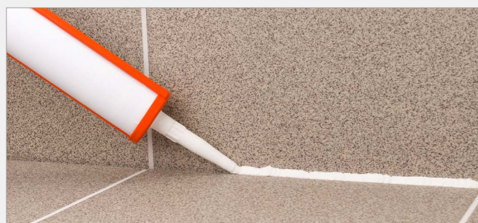
Wygładzanie spoin uszczelniających/klejowych
