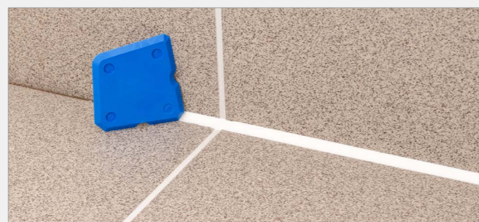
Ręczne wygładzanie szpatełką z tworzywa sztucznego
