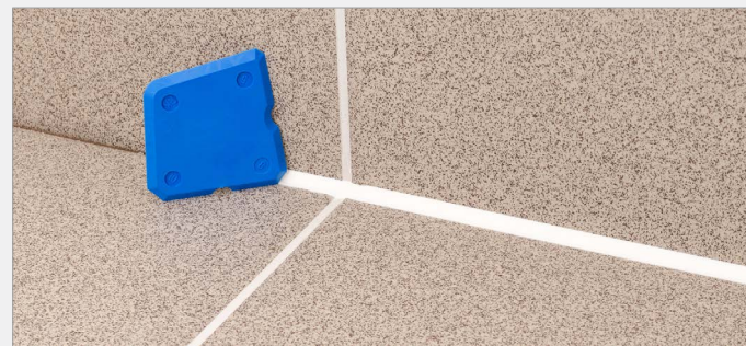
Händische Abglättung, mithilfe von Kunststoffspatel
