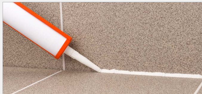
Abglätten von Dicht- / Klebefugen
