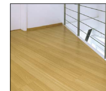
Encolado de tarimas
